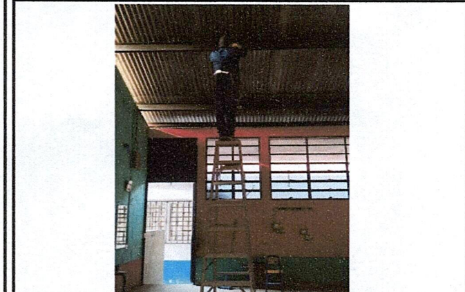
Foto 3: COLOCANDO NUEVA INSTALACION ELECTRICA EN AULAS
