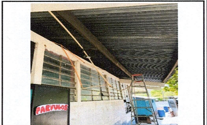
Foto 2: HACIENDO CAMBIO DE ELECTRICIDAD EN CORREDORES.
